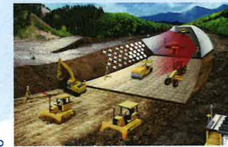
3D-MCは3次元デジタルデータによって重機の排土板を設計画通りに制御するマシンコントロール技術です。
