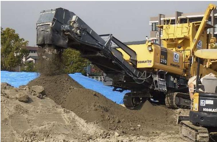
リテラ(移動式改良機)を使用した改良状況と「作り置き」(保管)状況
